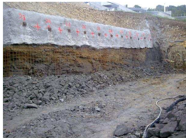
Beispiel einer Böschungssicherung durch eine Nagelwand
