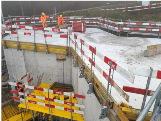
Baumeisterarbeiten neues Reservoir
