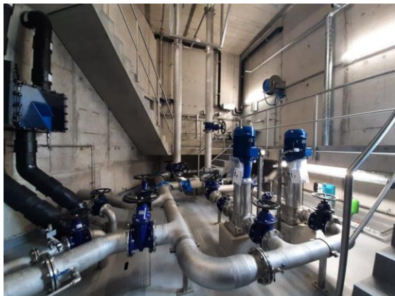
Innenausbau des Reservoirs
