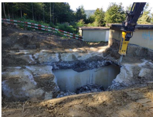
Abbruch der Reservoirs 1900 und 1908
