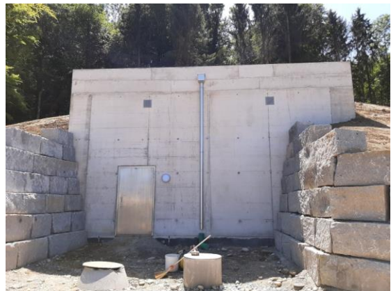
Fertiggestelltes Reservoir Dorf
