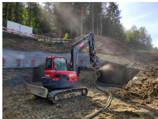
Erstellung der Nagelwand zur Sicherung der Baugrube
