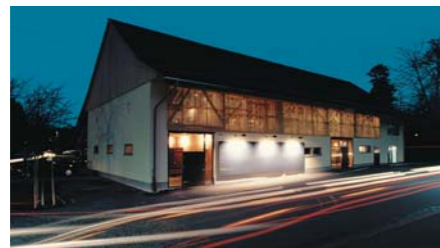
8 Mehrzweckgebäude mit Saal und Jugendkafi Bahnhofstrasse 24
