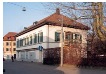
19 Wohn-Geschäftshaus um 1860/70 Bahnhofstrasse 12
